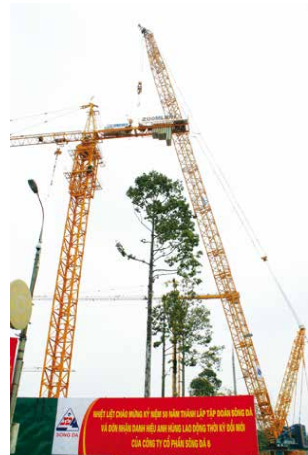
Cầu trục tháp Potain và cầu 1200 tấn thi công tại Nhà Quốc Hội và Hội trường Ba Đình mới
