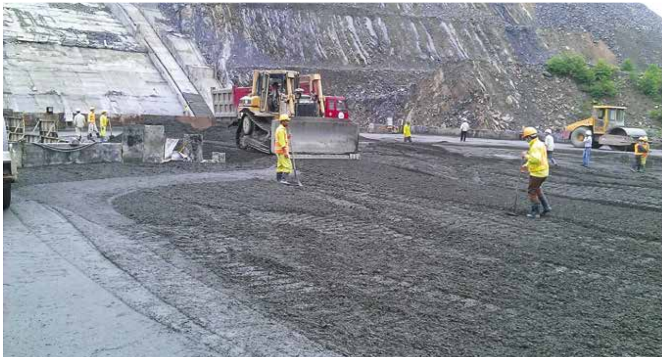
Công nghệ thi công đầm lặn trên công trình thủy điện Đồng Nai 5
